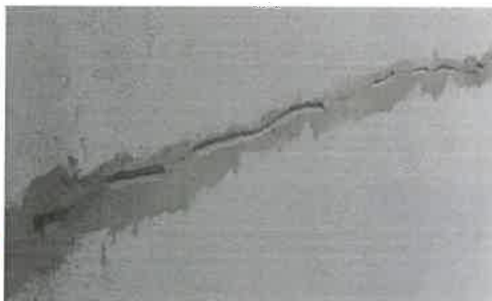
Fot. 4.20 – Na elewacji tylnej oraz na elewacji klatki schodowej Igielna 8 zaobserwowano widoczne miejsca gdzie wykonano naprawy zarysowań jednakże doszło na nich do znacznego wykruszenia zaprawy szpachlowej
