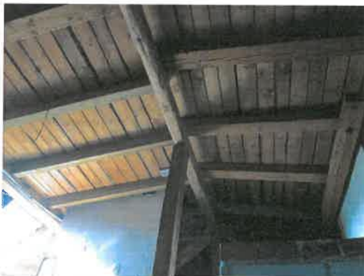
Fot. 3.2. Widok ogólny na drewnianą konstrukcję dachu
