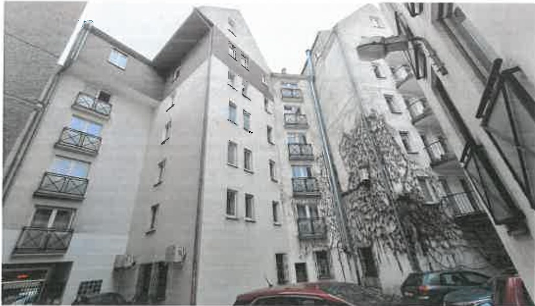
Fot. 3.11. Widok ogólny na elewację tylną wraz z balkonami
