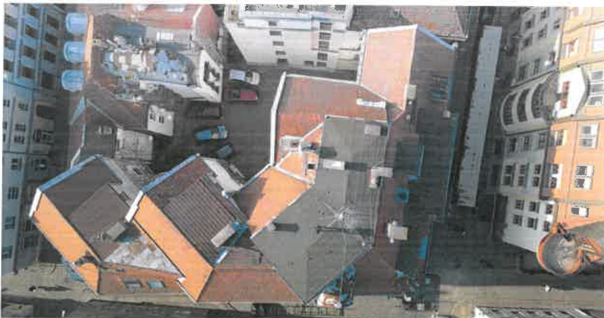
Fot. 3.1. Widok ogólny (z drona) wielopołaciowego dachu
