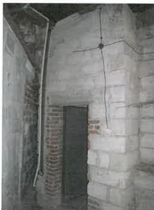
Fot. 3.8. Widok konstrukcji ścian z bloczków silikatowych na poddaszu budynku
