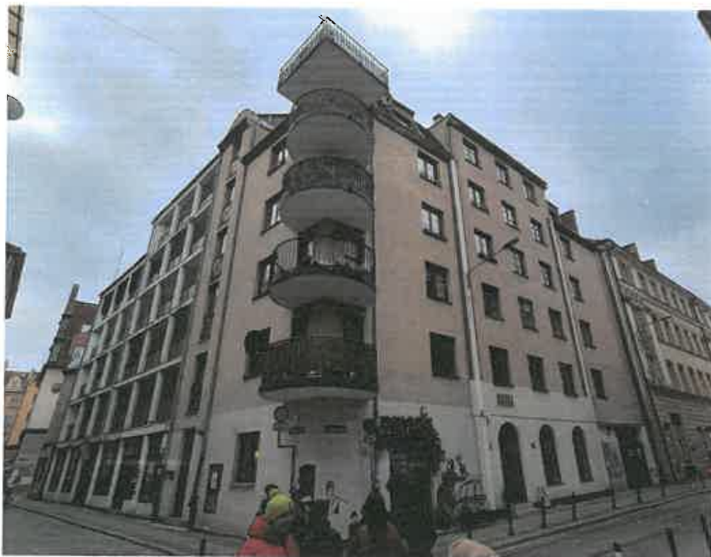
Fot. 3.9. Widok ogólny na elewację frontową, galerię i balkony – narożnik Kotlarska/Więzienna
