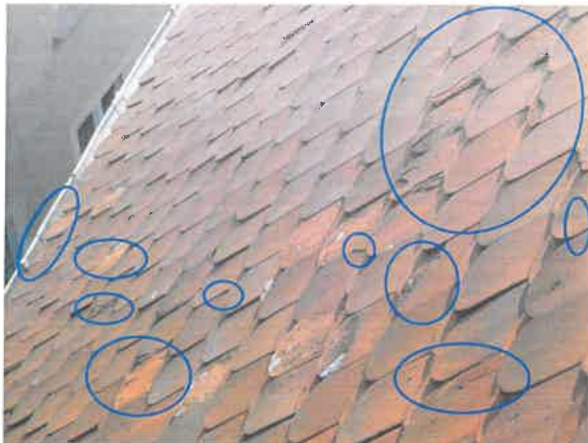
Fot. 4.2. Dachówki są nasiąkliwe i łuszczące się
