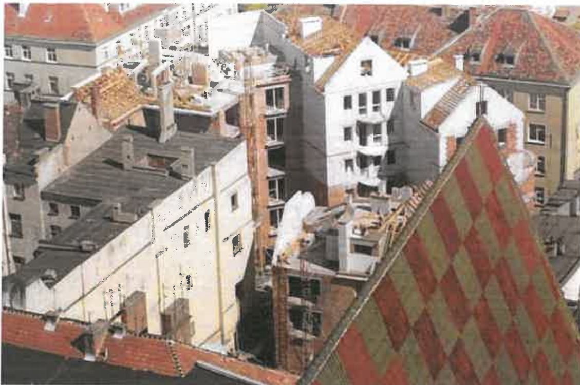
Fot. 3.7. Widok konstrukcji ścian z cegły dziurawki pustaków ceramicznych i bloczków silikatowych – elewacja tylna – zdjęcie z 1989 r.
