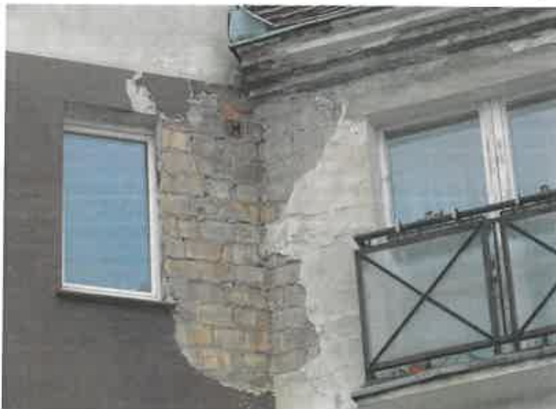
Fot. 3.6. Widok konstrukcji ścian z pustaków ceramicznych - elewacja tylna od Więziennej
