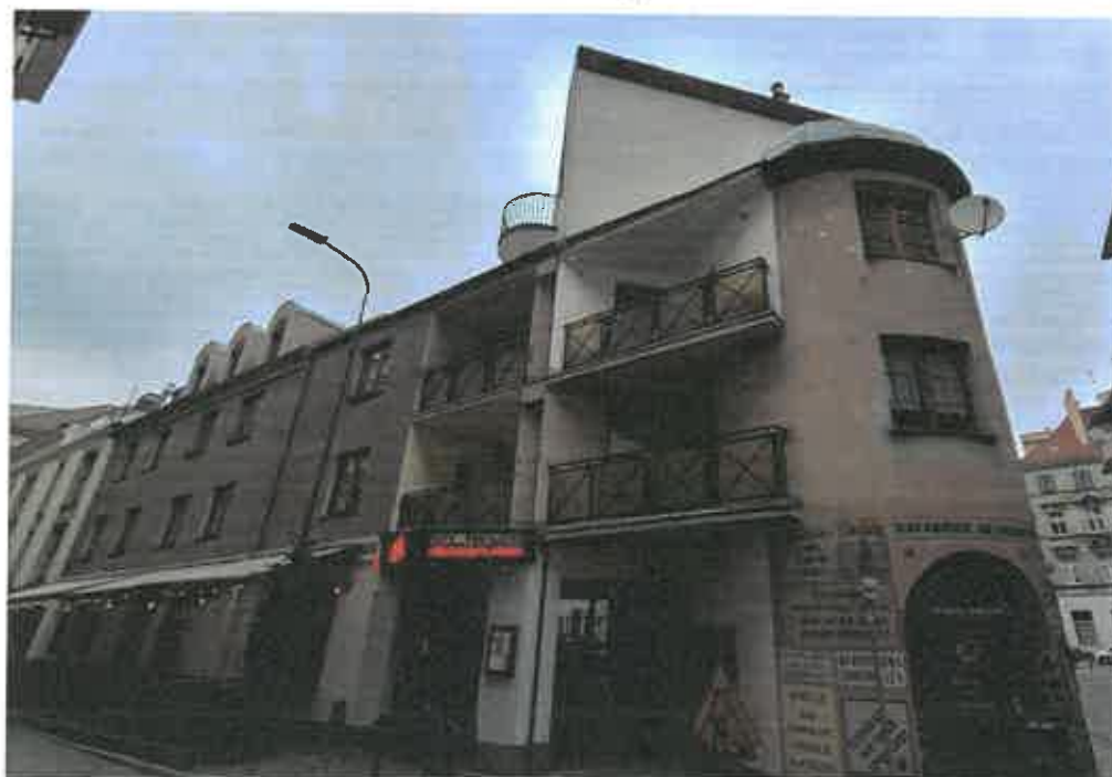
Fot. 3.10. Widok ogólny na elewację frontową i balkony (loggie) – Igielna
