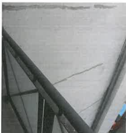
Fot. 4.20 – Na elewacji tylnej oraz na elewacji klatki schodowej Igielna 8 zaobserwowano widoczne miejsca gdzie wykonano naprawy zarysowań jednakże doszło na nich do znacznego wykruszenia zaprawy szpachlowej
