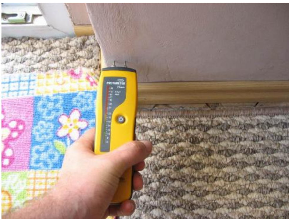
Fot.22 Badania zwilgocenia ściany - odczyt 11 - wilgotność masowa 2,5% - ściana sucha
