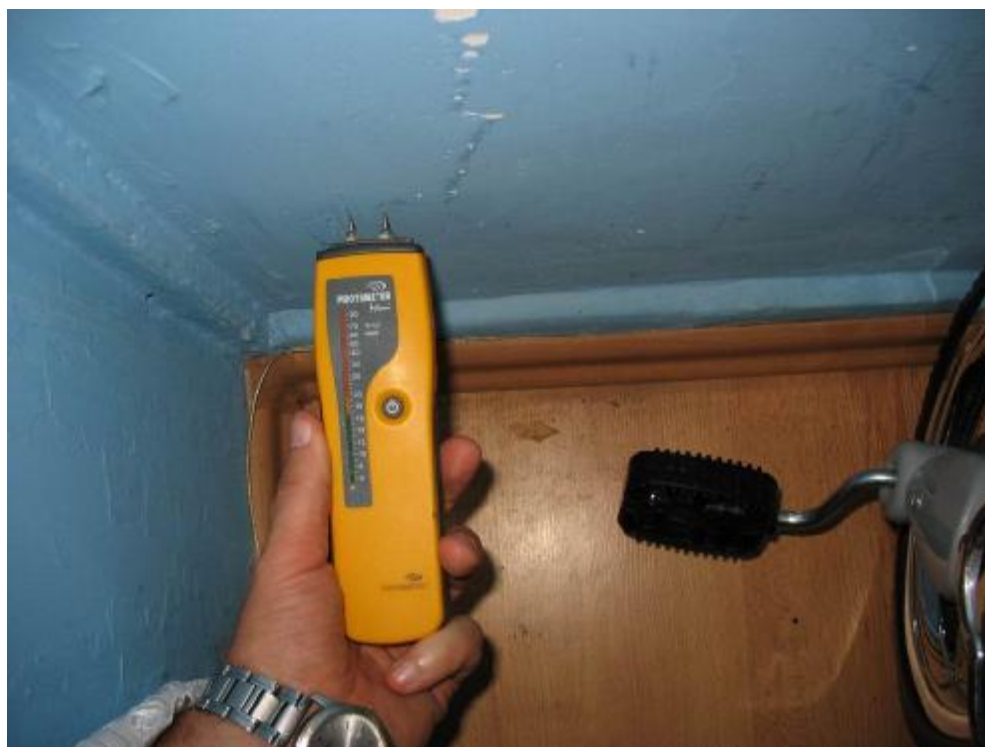
Fot.24 Badania zwilgocenia ściany - odczyt 7 - wilgotność masowa 1% - ściana sucha
