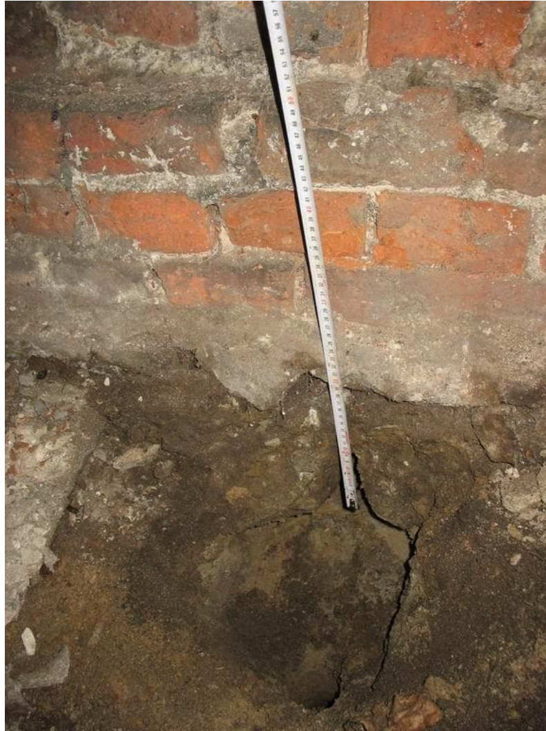
Fot.73 Widok na wykonaną odkrywkę
