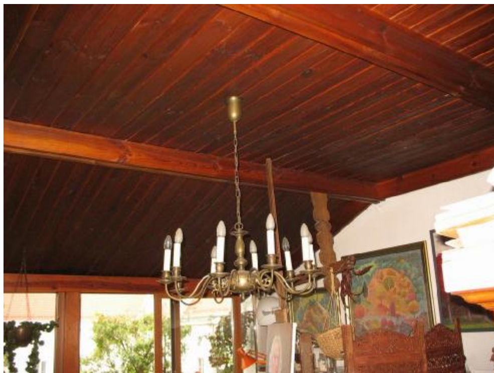
Fot.47 Widok na stropodach mieszkania
