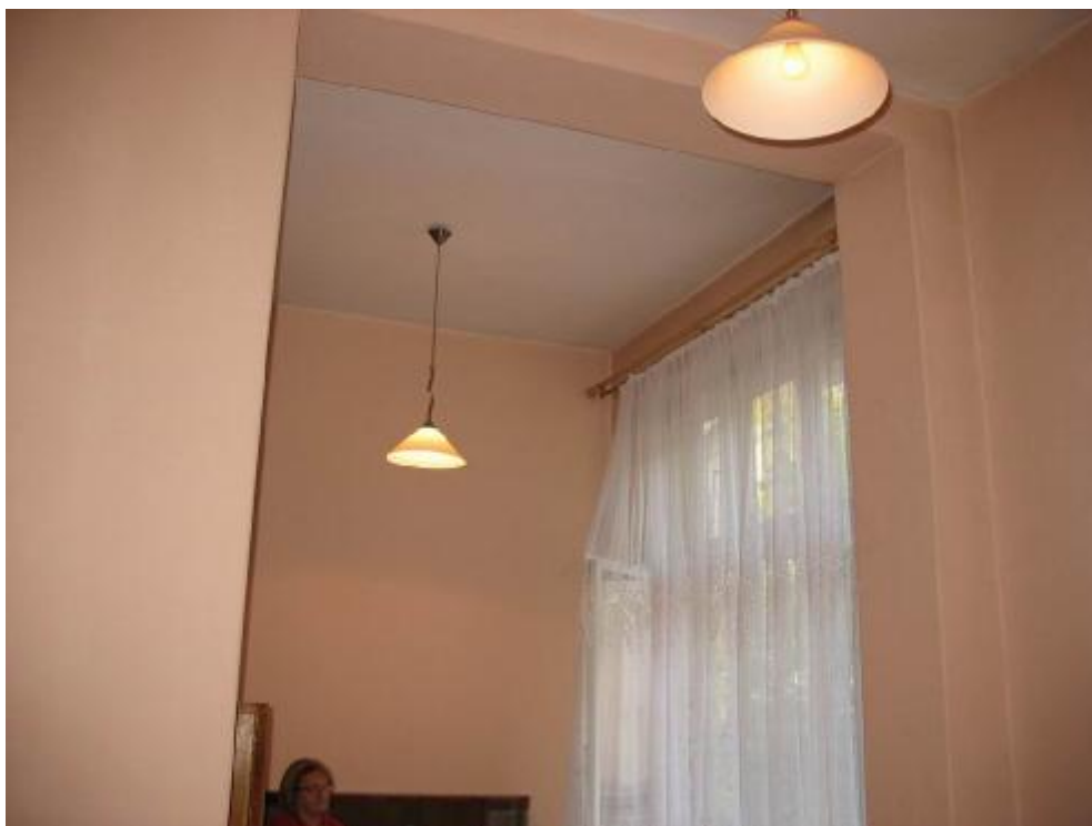
Fot.21A Widok ogólny na ścianę szczytową
