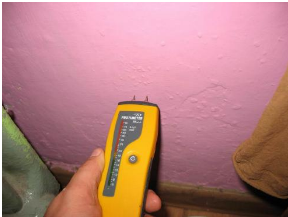
Fot.29 Badania zwilgocenia ściany - odczyt 11 - wilgotność masowa 2,2% - ściana sucha
