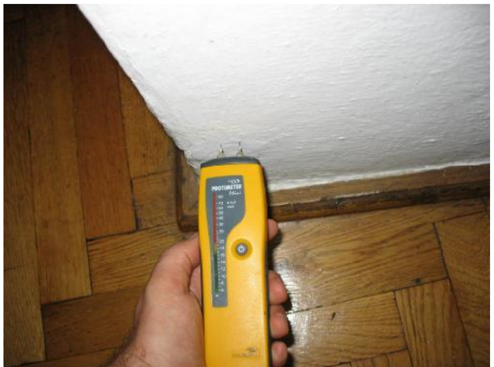
Fot.50 Badania zwilgocenia ściany - odczyt 7 - wilgotność masowa 1% - ściana sucha
