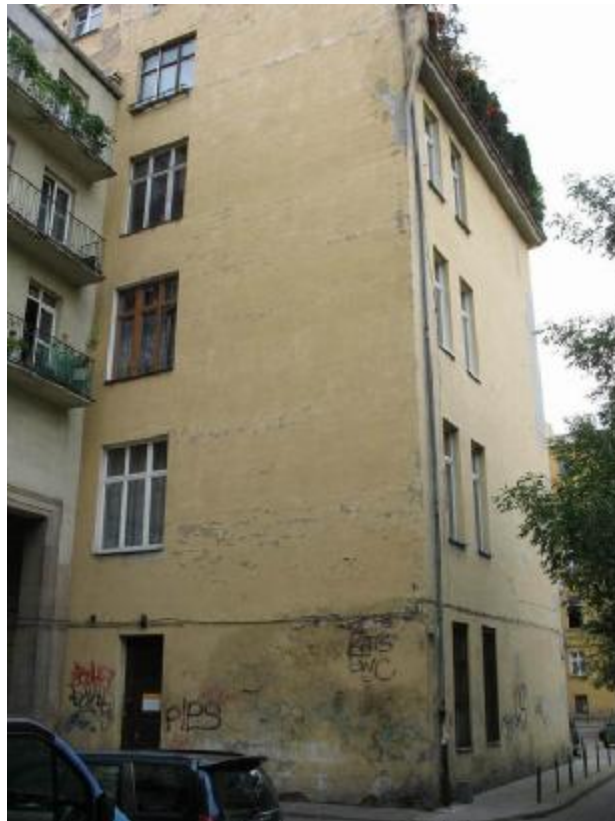
Fot.3 Widok na elewację szczytową
