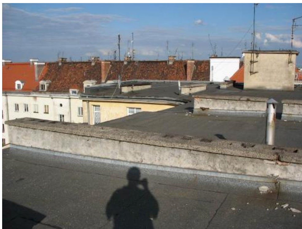
Fot.66 Widok na dach
