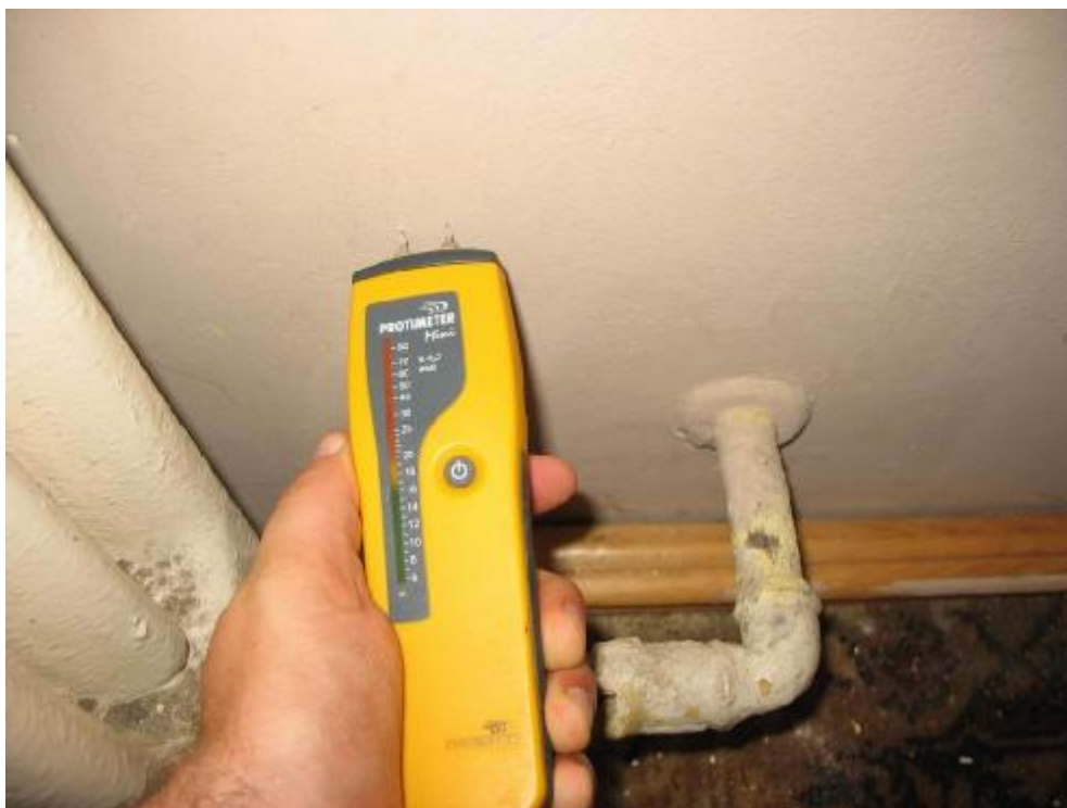
Fot.40 Badania zwilgocenia ściany - odczyt 11 - wilgotność masowa 2,5% - ściana sucha
