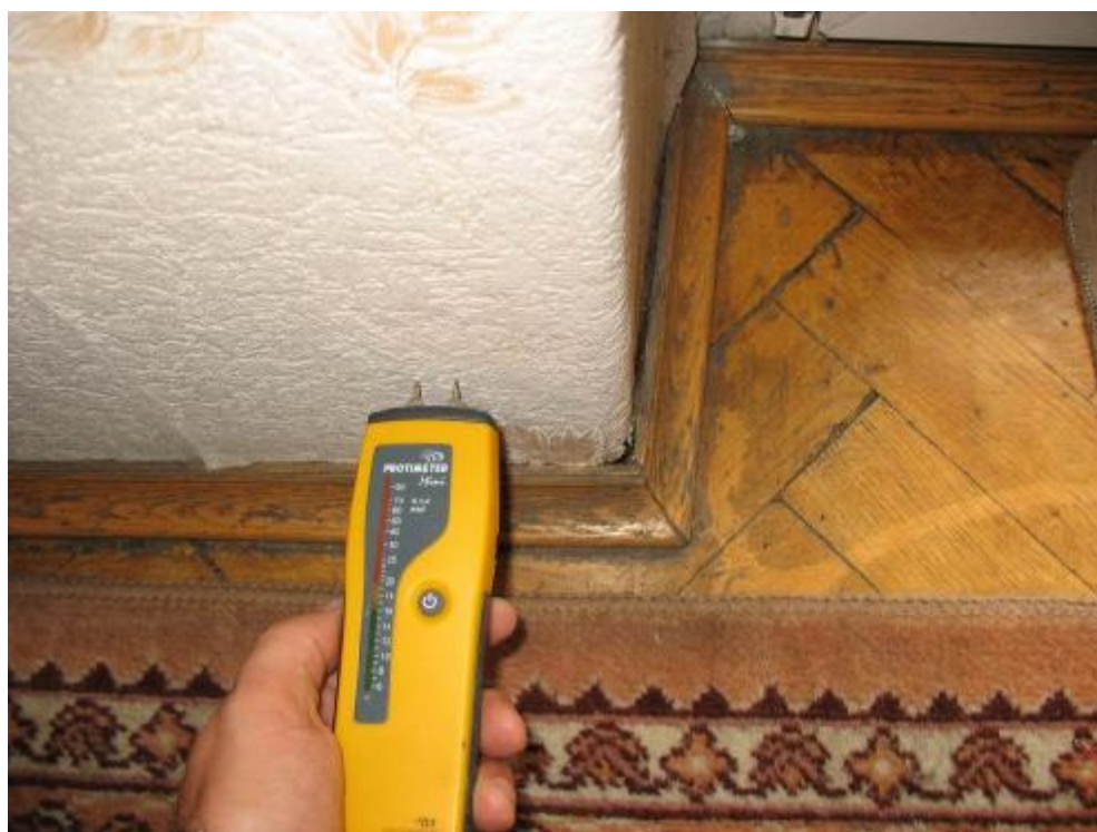
Fot.18 Badania zwilgocenia ściany - odczyt 8 - wilgotność masowa 1% - ściana sucha
