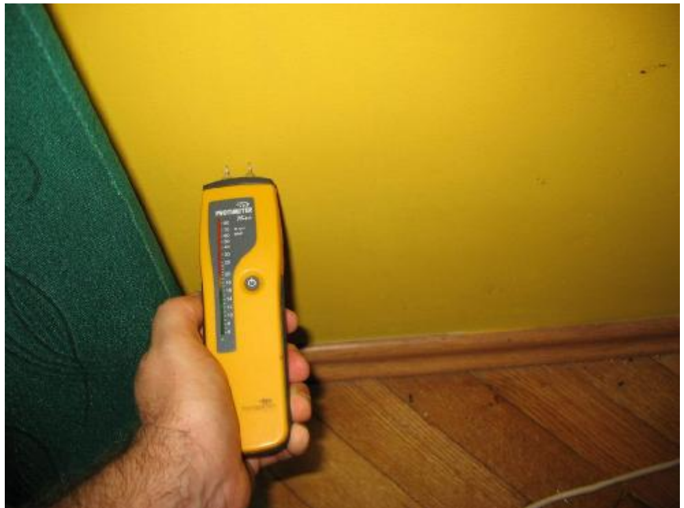
Fot.35 Badania zwilgocenia ściany - odczyt 13 - wilgotność masowa 3% - ściana sucha
