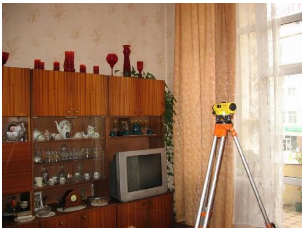
Fot.19 Badania ugięć stropu przeprowadzono niwelatorem optycznym Leica Runner 24
