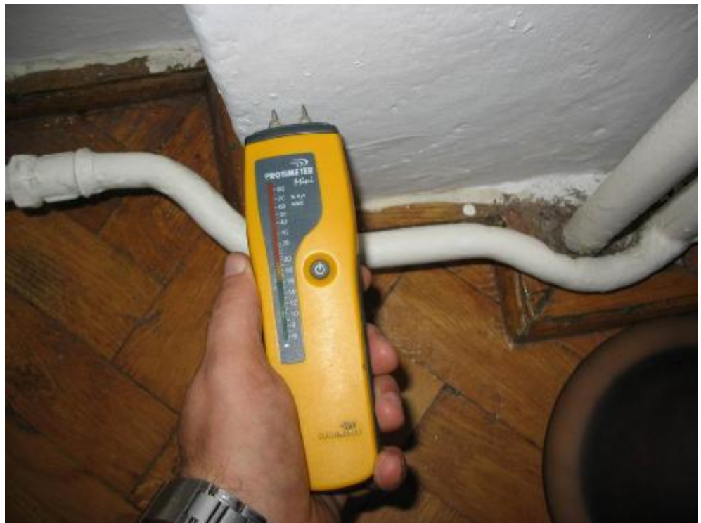
Fot.26 Badania zwilgocenia ściany - odczyt 12 - wilgotność masowa 2,5% - ściana sucha
