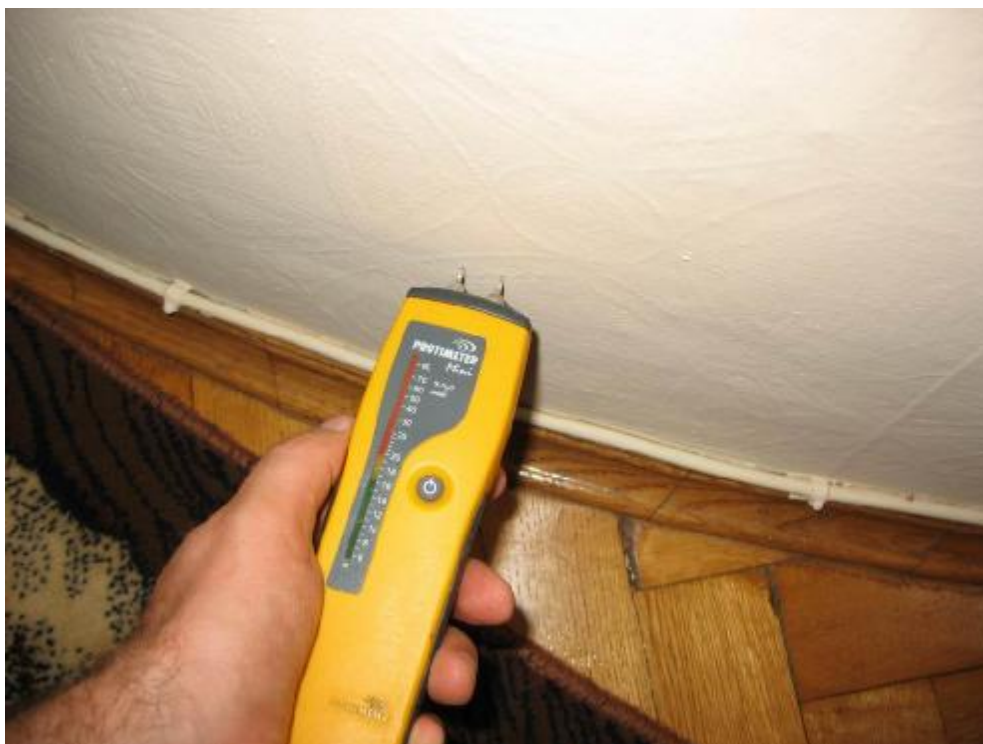
Fot.44 Badania zwilgocenia ściany - odczyt 15 - wilgotność masowa 3,5% - ściana sucha
