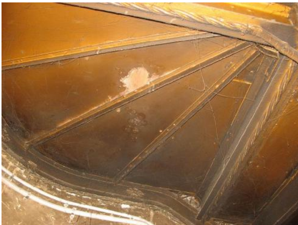
Fot.58 Schody w części nad parterem
