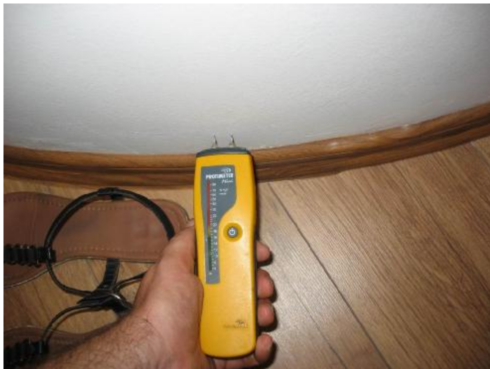
Fot.51 Badania zwilgocenia ściany - odczyt 11 - wilgotność masowa 2,5% - ściana sucha
