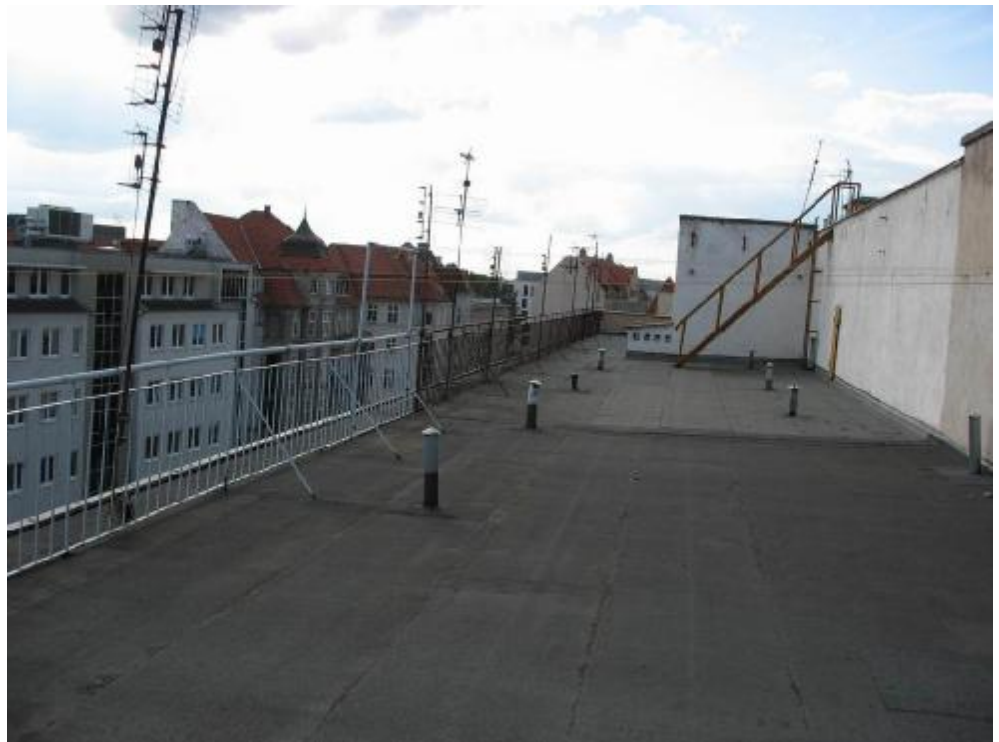
Fot.63 Widok na część niższą dachu
