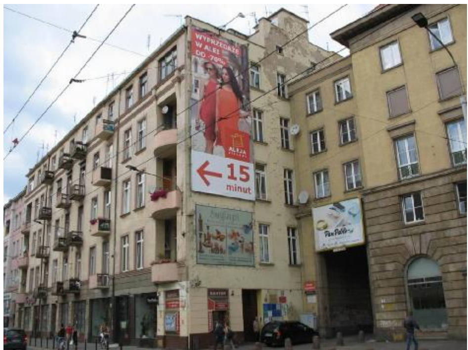
Fot.2 Widok na elewację frontową i boczną ściany szczytowej
