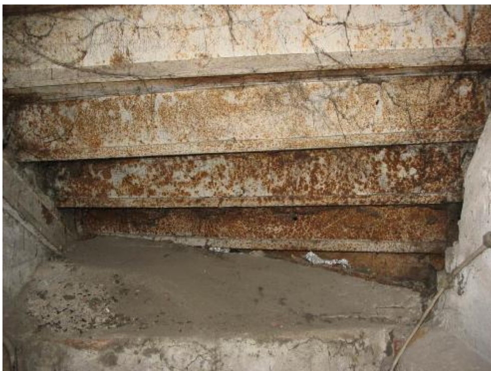
Fot.57 Schody w części nad piwnicą
