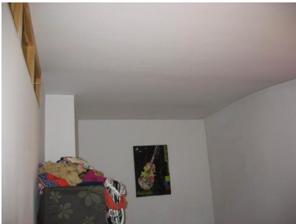
Fot.55 Stan techniczny dobry
